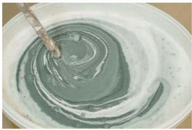
6. Mit einem Rührgerät die Pigmentmischung in die Farbe gleichmäßig einrühren.
